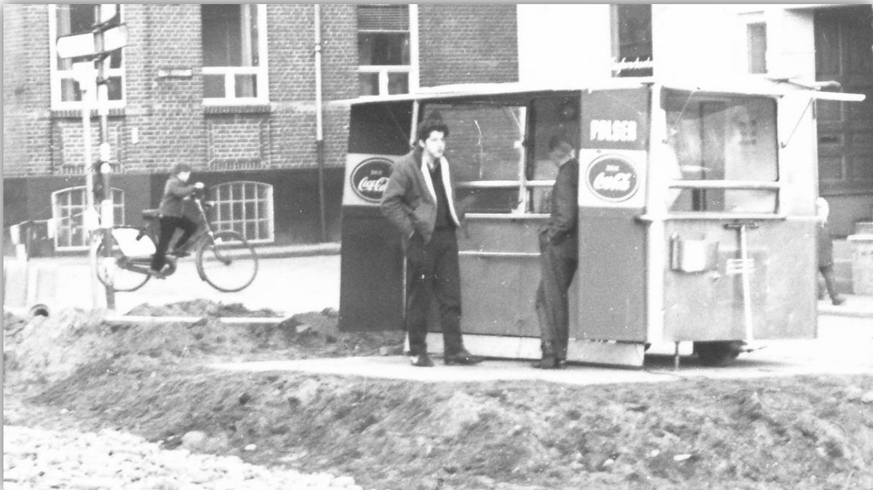
Billedet er taget midt under ombygningen på Brotorvet i midten af 1960'erne. Nu var det åbenbart ikke så ilde set mere, at kvinder frekventerede ved en pølsevogn!
